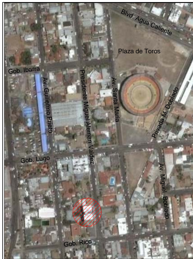
Figura 5: Vista aérea de la ubicación del edificio, señalado en círculo sombreado con líneas.
